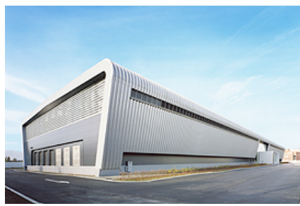
2011年11月に開設された国内最大級の郊外型データセンターである「石狩データセンター」の外観
